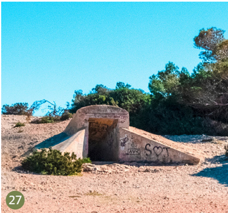
27 KÜSTENBATTERIE SA CALETA
